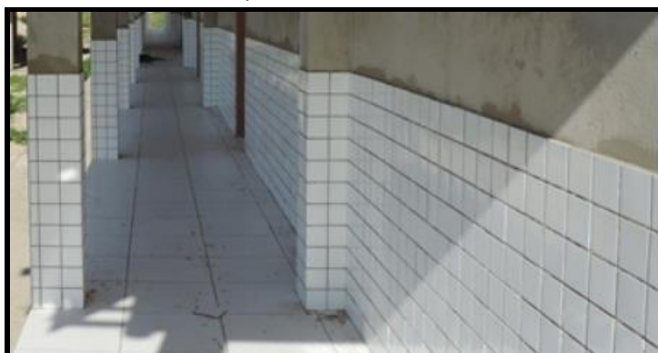
Imagem 12 – Ilustrativa: Parede com barrado impermeável
